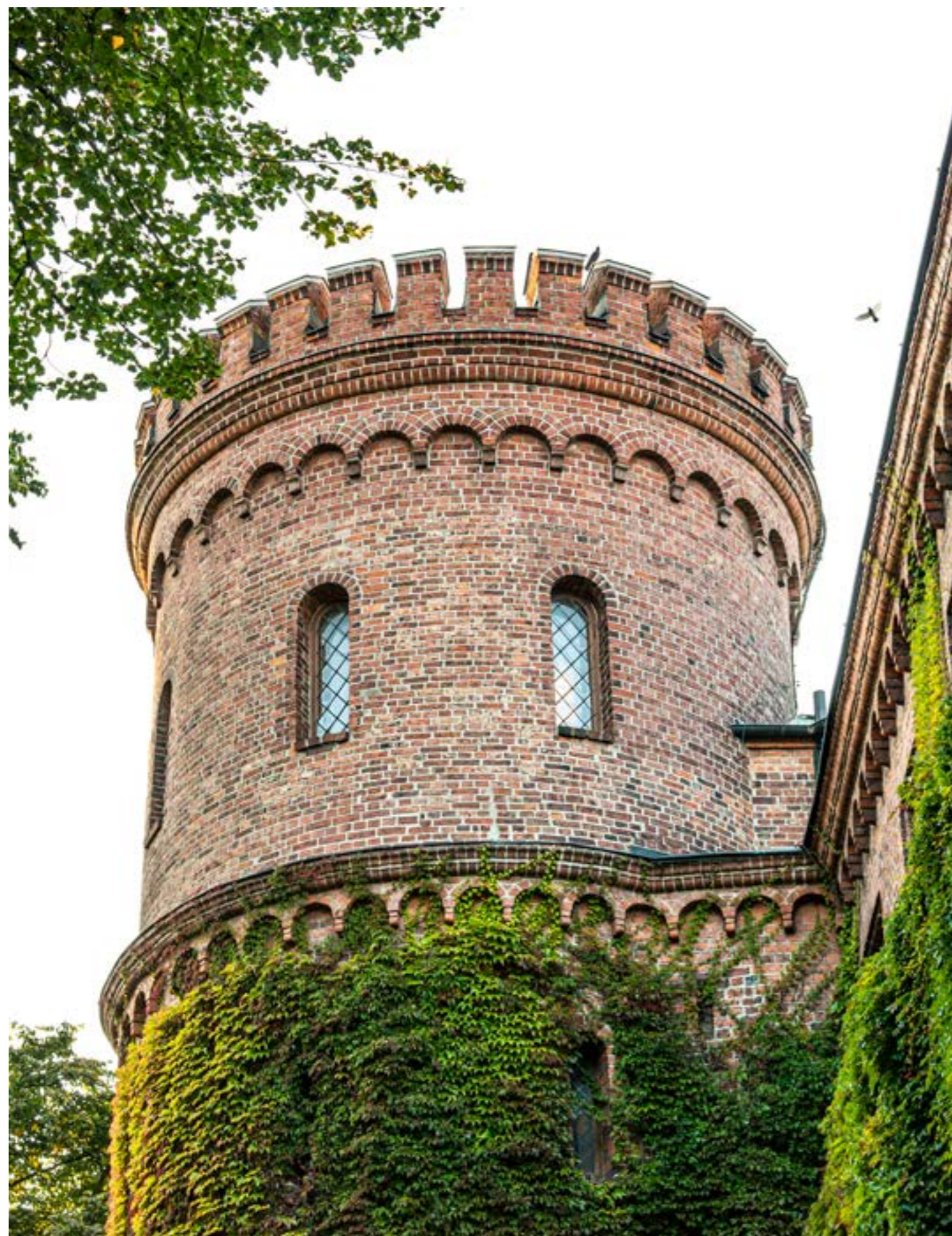
DET BERÖMDA KUNGSHUSET I LUNDAGÅRD, DÅR CARL XII ENLIGT SÅGNET EN GÅNG RIDIT UPP FÖR TRAPPORNA. KUNGSHUSET FUNGERADE SOM UNIVERSITETS HUVUDBYGGNAD TILL IN PÅ 1880-TALET, DÅ DET NUVARANDE UNIVERSITETSHUSET STOD KLART.
